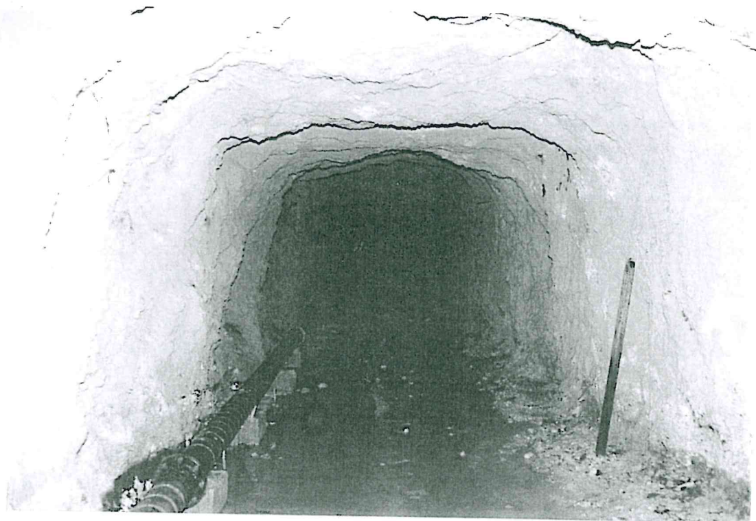
Foto 5 - Sorgente Moresco Galleria. Vista interna, sul lato sinistro la condotta di mandata dal sondaggio produttivo, sul lato destro un palo di legno ed altri residui abbandonati.
