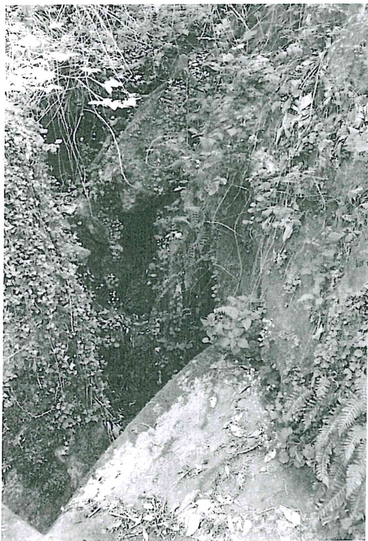
Foto 2 - Sorg. Molini di Sant'Anna. La zona di risorgenza protetta dalle acque del torrente con un manufatto in CLS.
