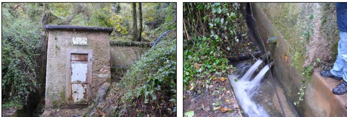
Fig. 4.10: Bottino di presa della sorgente Molini di S. Anna (a sinistra) e i relativi tubi di scarico (a destra).
