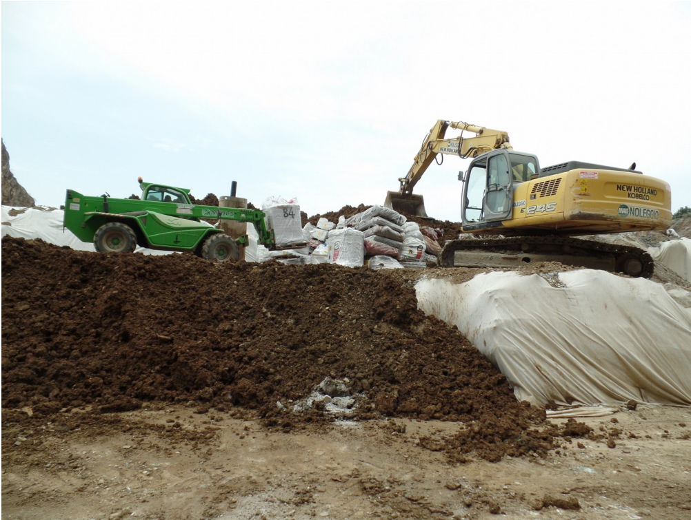
Foto 7: scarico messa a dimora e copertura RCA
