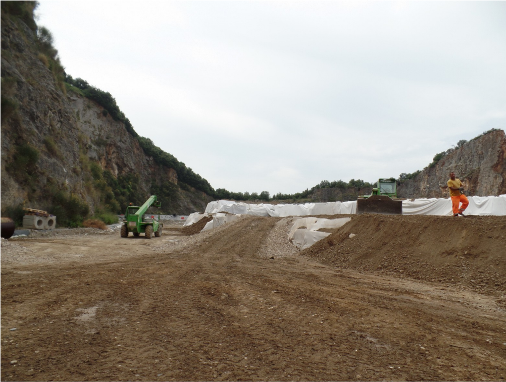
Foto 3: piazzale di scarico e messa a dimora
