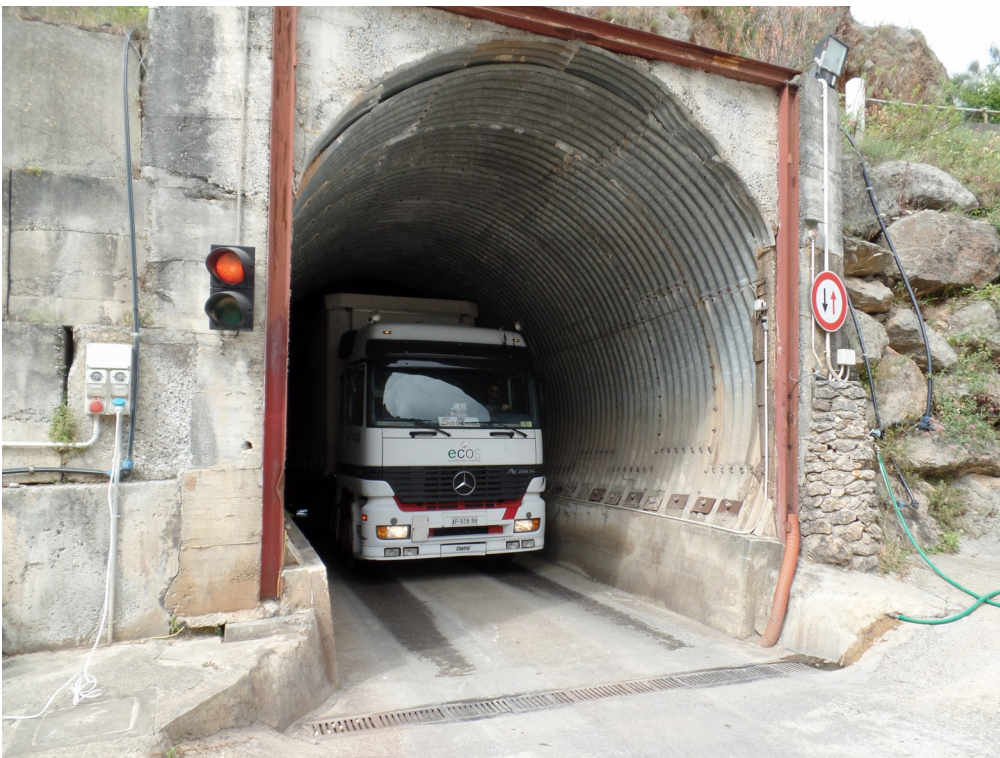
Foto 2: tunnel di entrata/uscita
