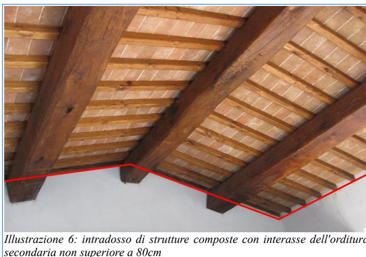
*Illustrazione 6: intradosso di strutture composte con interasse dell'orditura secondaria non superiore a 80cm*
