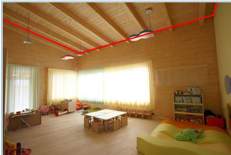
*Illustrazione 7: intradosso di strutture composte con interasse dell'orditura secondaria superiore a 80cm*
