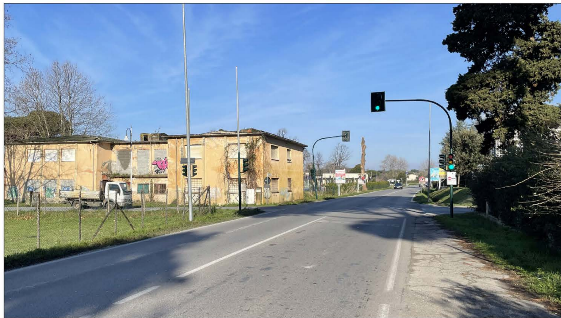
Stato attuale - Vista direzione Marina di Pietrasanta
